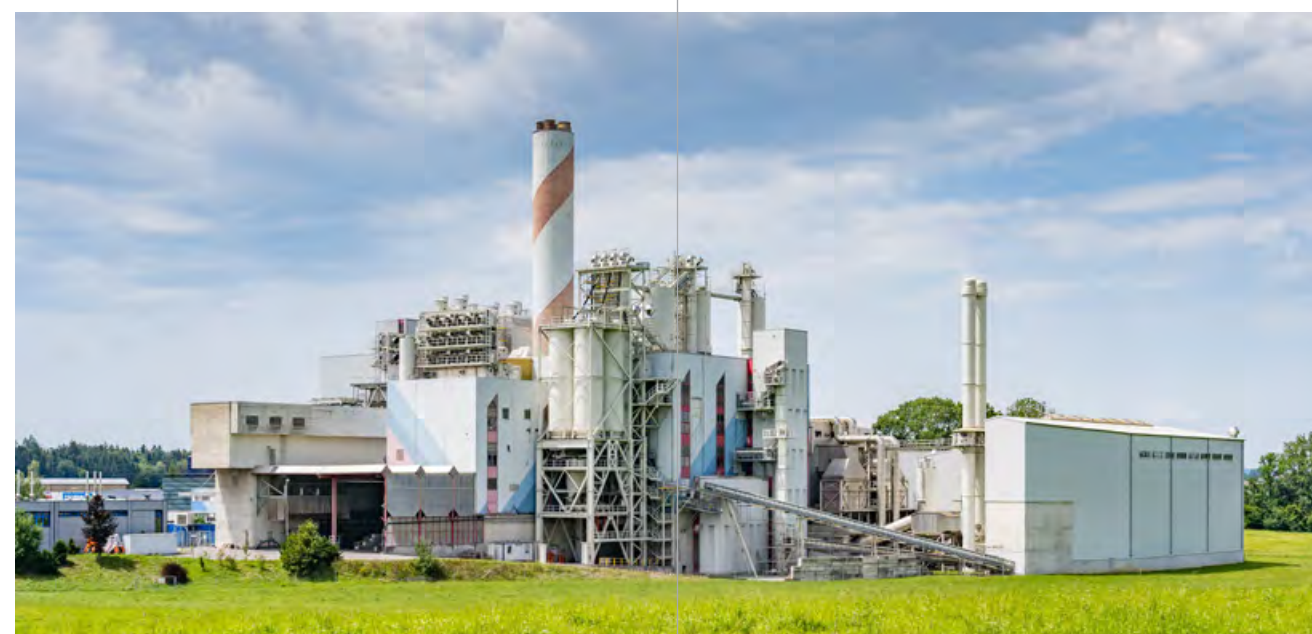
Seit 2017 steht in Hinwil, unweit von Zürich, eine Pilotanlage des Schweizer Unternehmens Climeworks zur Filterung von CO 2 aus der Luft. Climeworks hat im September 2021 die weltweit größte sogenannte Direct Air Capture (DAC) Anlage auf Island eröffnet.
