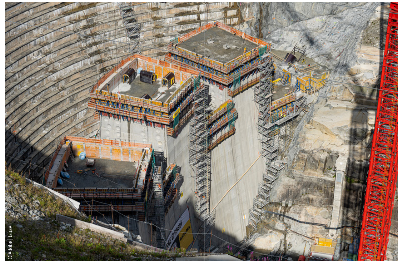
Neubau der Spittelamm-Staumauer am Grimselpass in der Schweiz. Das Megaprojekt soll 2025 fertig sein.
